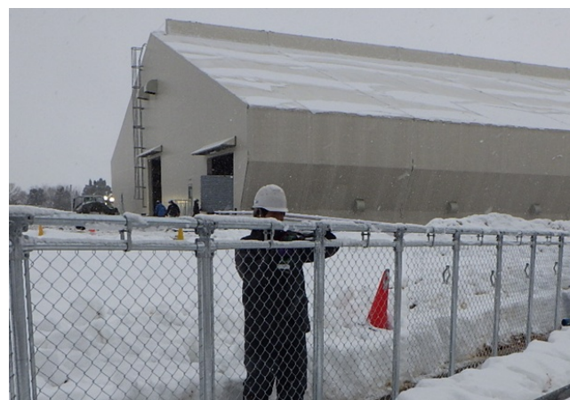
写真 2.3 積雪深 60 cm 時の屋根堆雪状況
