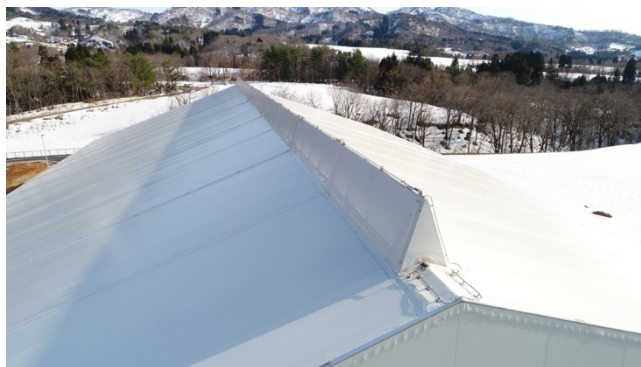
写真 2.2 被覆施設(屋根傾斜 35%、雪割)
