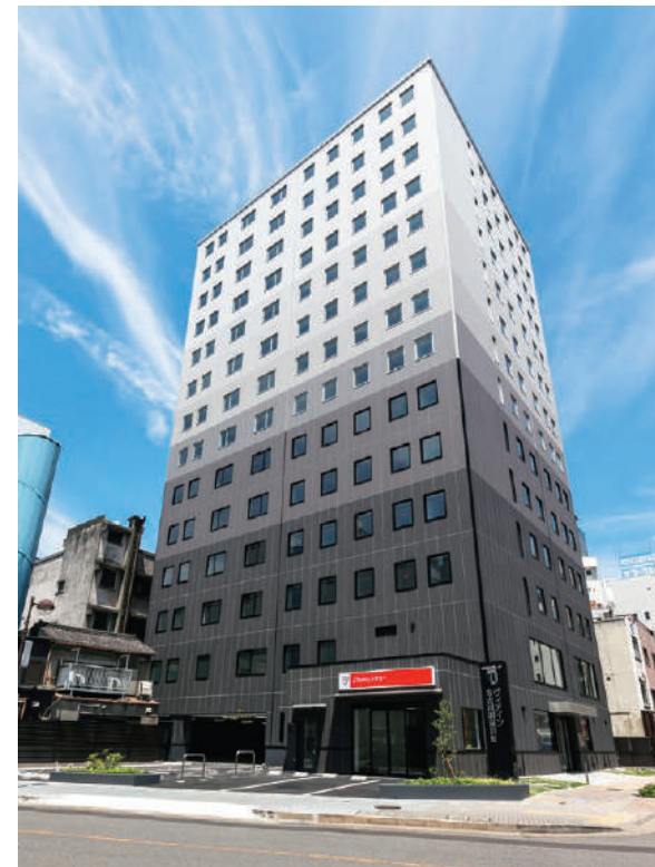
ヴィアイン 名古屋駅前椿町／愛知県 発注者：芙蓉総合リース㈱ ■概要：S造、14階、249室、延床面積5,755.780㎡
