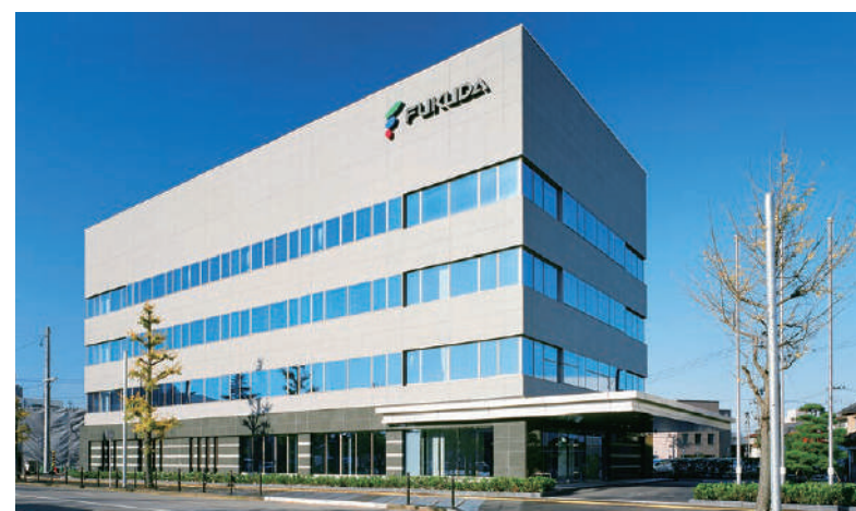
平成28年 福田組本社社屋
