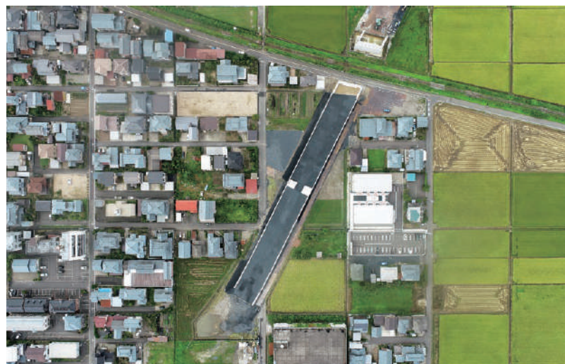
3・4・5東南環状線広域連携(物流街路)道路改良(寺沢)工事 ／新潟県 発注者：新潟県 ■概要：(実)延長156.1m No.49+14.0～No.57+10.1 補強土壁工1,179㎡ アンカー補強土壁 ボックスカルバート17.0m 場所打ちボックスカルバートB5,500×H4,600 固化処理工14,948㎡ 粉体噴射攪拌式 杭径φ1.0m、杭長1.2～6.8m、本数3,122本
