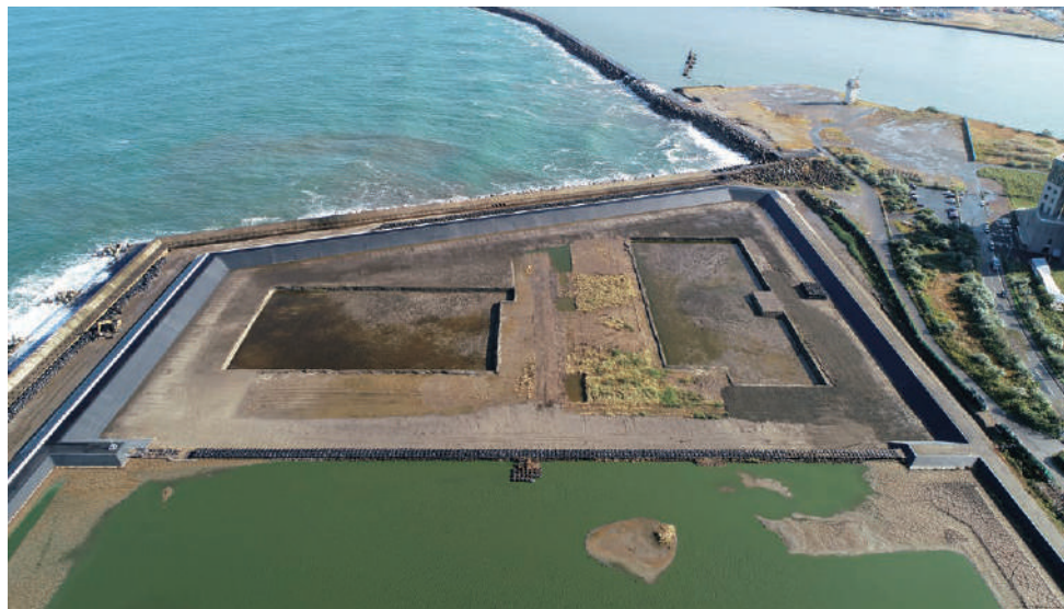
新潟港(西港区)廃棄物埋立護岸管理 浚渫土砂樹築堤その8工事 ／新潟県 発注者：新潟県
