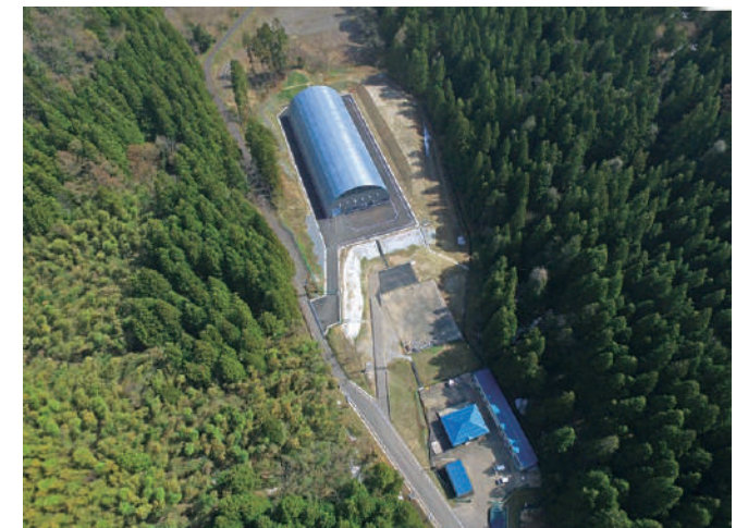
糸魚川市一般廃棄物最終処分場
