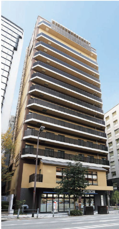
天然温泉 花波の湯 御宿 野乃 大阪淀屋橋／大阪府 発注者：㈱共立エステート ■概要：RC造、13階、160室、延床面積5,243.66㎡
