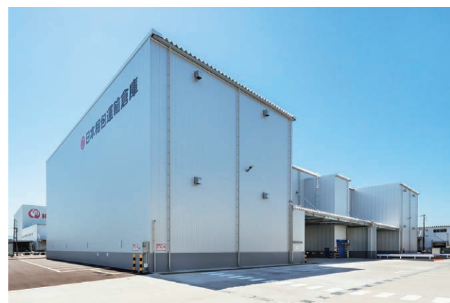
日本梱包運輸倉庫株式会社 白根営業所／新潟県 発注者：日本梱包運輸倉庫株式会社 ■概要：S造、2階、物流施設・倉庫2棟、延床面積9,966.69㎡
