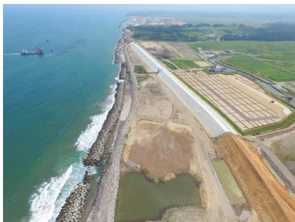
公共災害復旧(再復)工事(海岸)／福島県 発注者：福島県
