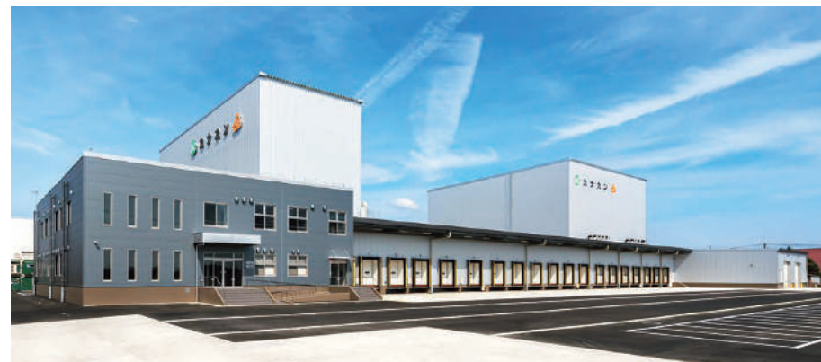
カナカン株式会社 長岡物流センター ／新潟県 発注者：カナカン株式会社 ■概要：S造、2階、事務所併設物流センター、 延床面積7,217.91㎡
