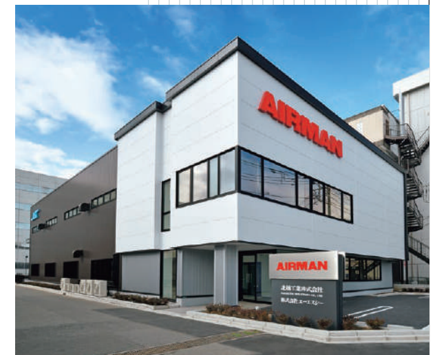
北越工業株式会社 西関東支店／神奈川県 発注者：北越工業(株) ■概要：S造、2階、延床面積885.75㎡
