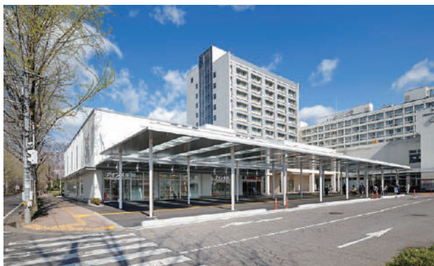
獨協医科大学病院アメニティ棟（アイン薬局）／栃木県 発注者：株式会社東急コミュニティー ■概要：S造、2階、延床面積1,919.47㎡
