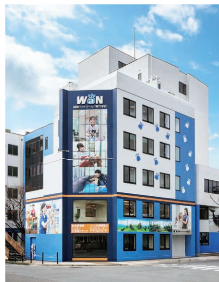
国際ペットワールド専門学校C棟／新潟県 発注者：(株)国際総合計画 ■概要：S造、5階+PH階、延床面積753.96㎡
