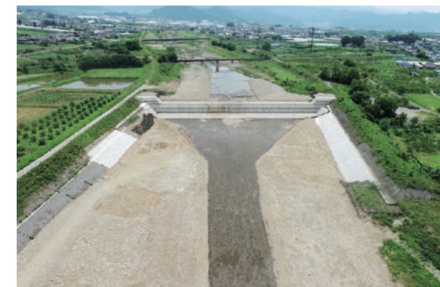
千曲川笠原床固工災害復旧工事 ／長野県 発注者：国土交通省北陸地方整備局 ■概要：作業土工1式 消波根固めブロック(6t型)製作据付3,345個 仮設工1式
