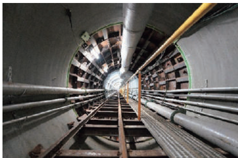
施工状況(推進管からセグメントへ)
