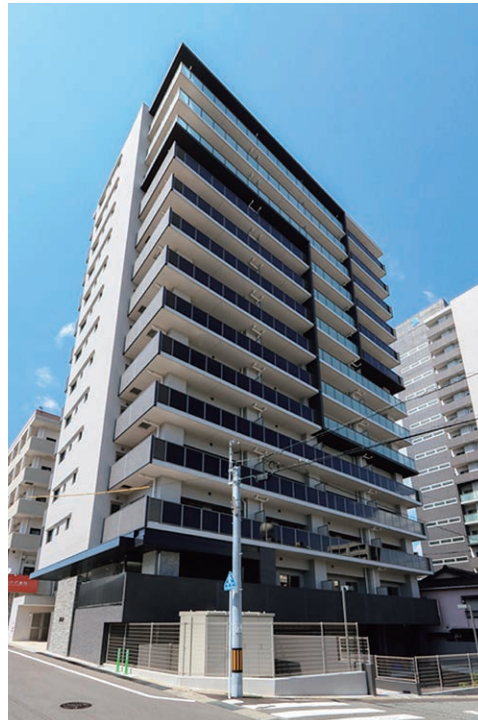
アルファステイツ住吉II／長崎県 発注者：穴吹興産㈱ ■概要：RC造、14階、分譲マンション51戸、延床面積4,943.92㎡
