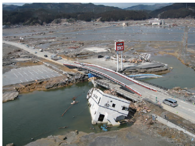
国道45号応急橋架設工事／岩手県 発注者：国土交通省東北地方整備局
