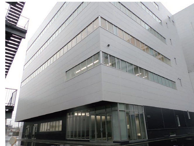
デンカ株式会社五泉事業所新潟工場 45号棟／新潟県 発注者：(株)デンカ ■概要：RC造、6階、事務所1棟、延床面積4,234.41㎡
